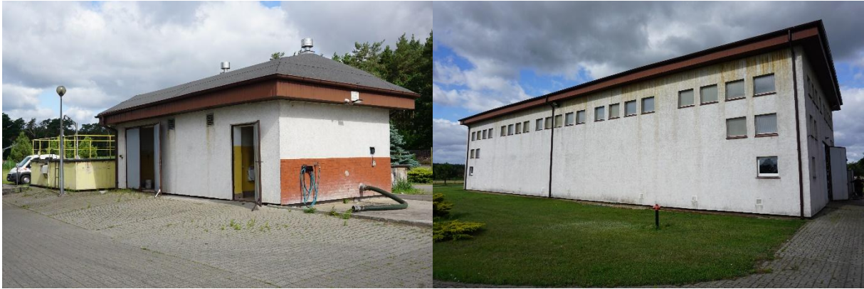
Budynek technologiczny - przyjmowanie nieczystości ciekłych. Budynek główny oczyszczalni z reaktorem biologicznym.
