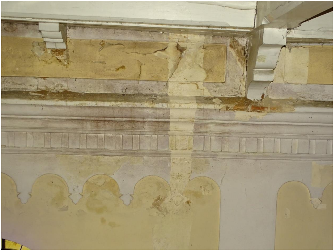
Fot. 43 Odkrywka 10 i 11 Detal architektoniczny w górnej części wschodniej ściany nawy
