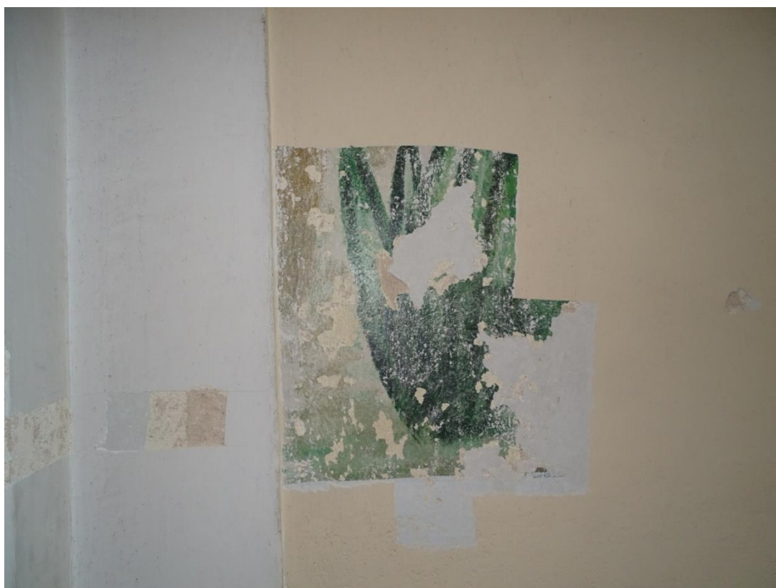
Fot. 38 Odkrywka 9 Południowa ściana nawy na wysokości drugiej kondygnacji empor po stronie zachodniej
