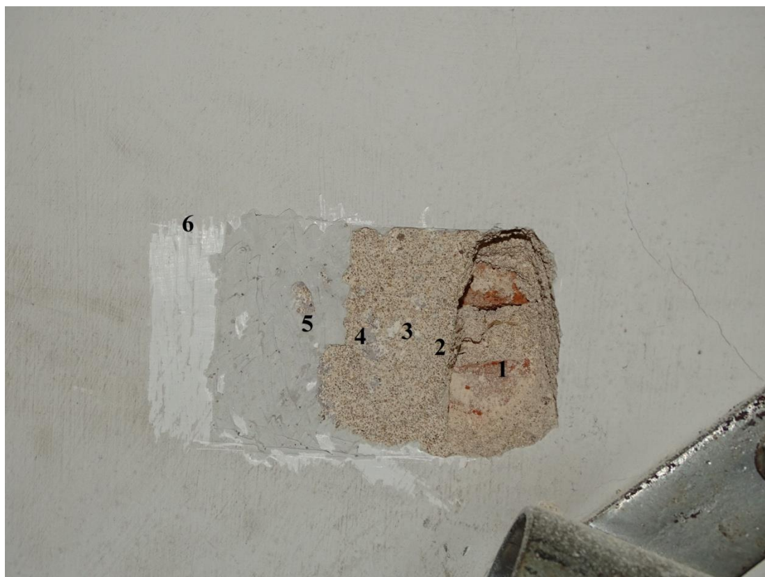
Fot. 33 Odkrywka 4 Płaszczyzna detalu architektonicznego - lizeny
