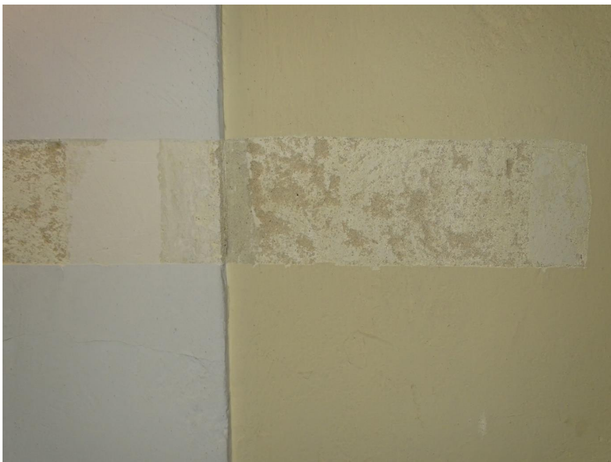
Fot. 30 Odkrywka nr 1 Część ścian nawy na drugiej kondygnacji
