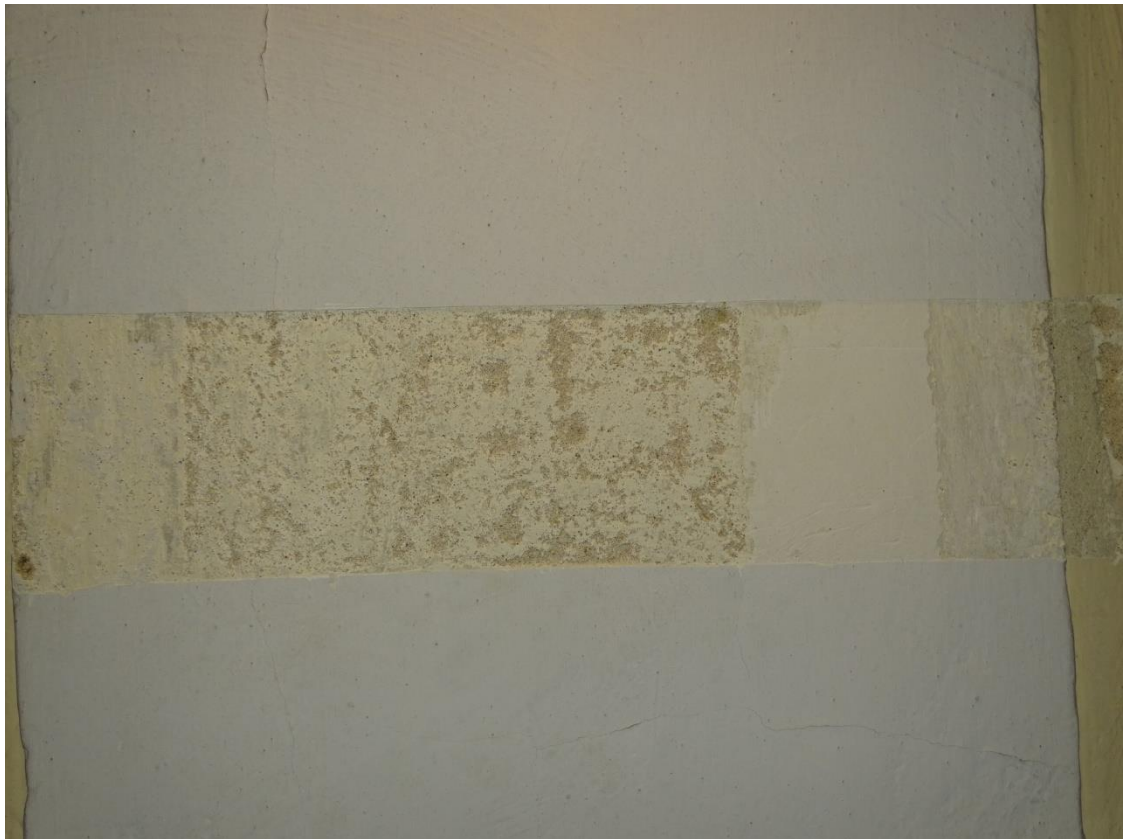
Fot. 46 Odkrywka 14 Detal architektoniczny - lizena w dolnej części zachodniej ściany nawy
