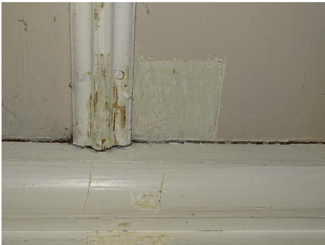
Fot. 57 Odkrywka 24 Odkrywka na powierzchni płyciny stropu nawy
