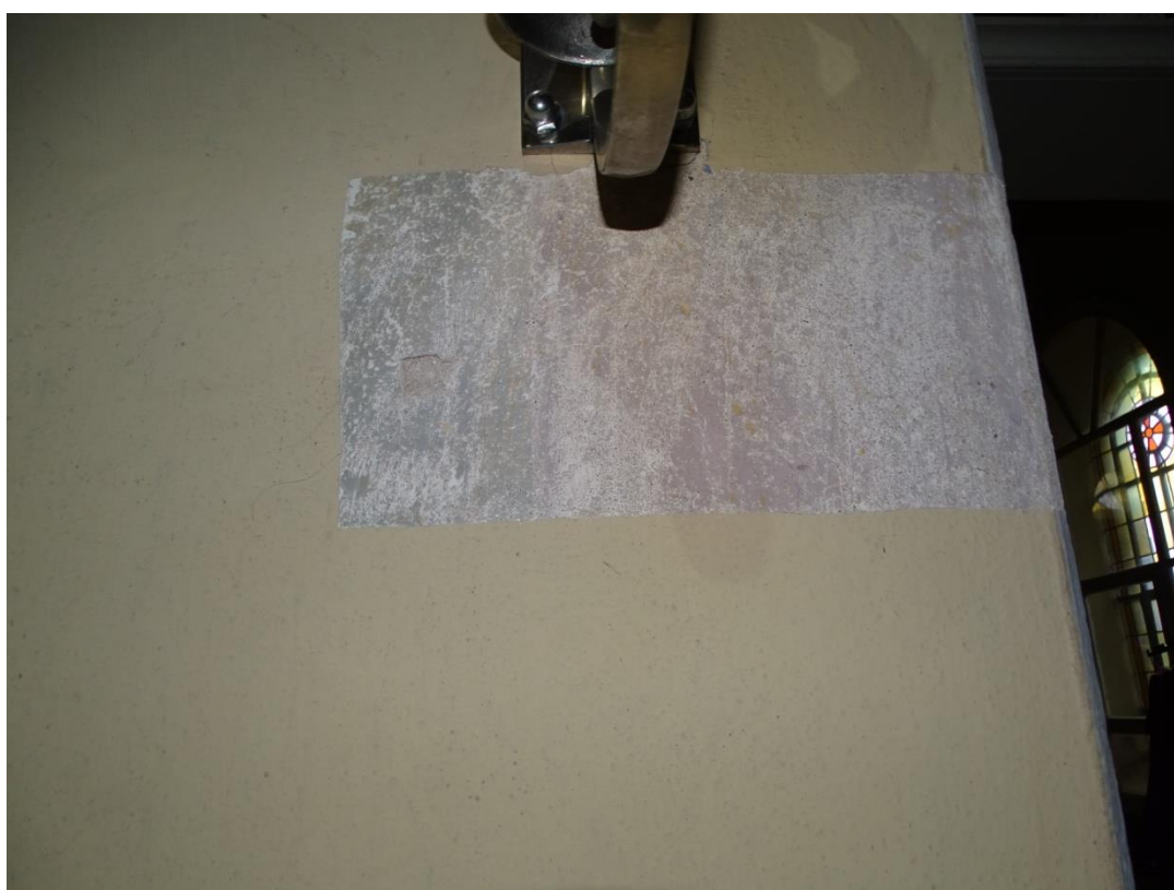
Fot. 55 Odkrywka 22 odkrywka na powierzchni ściany przy wejściu do zakrystii w prezbiterium
