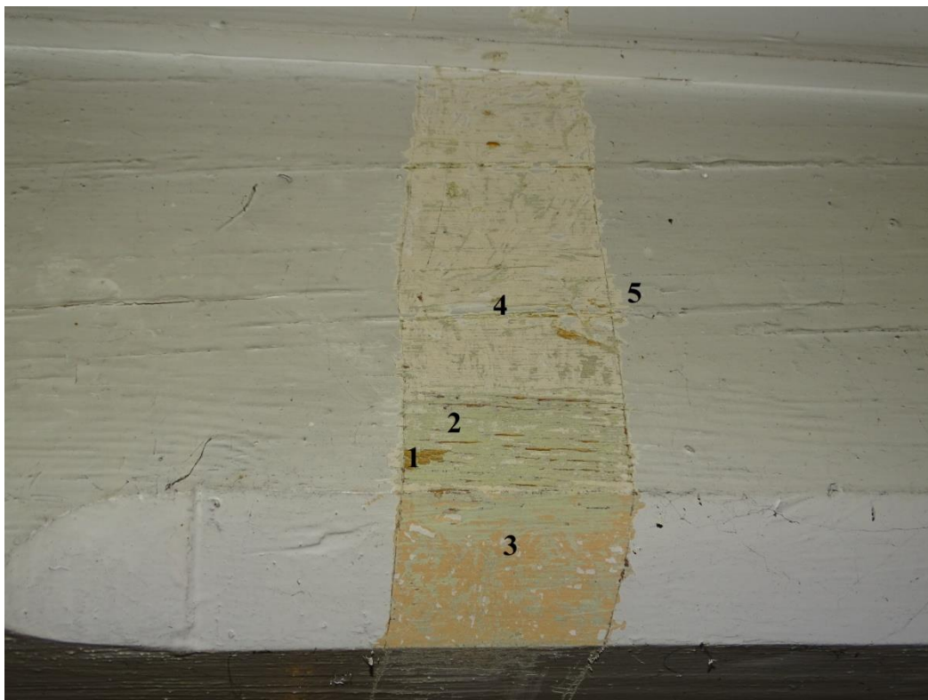
Fot. 56 Odkrywka 23 Odkrywka na powierzchni belki stropowej nawy
