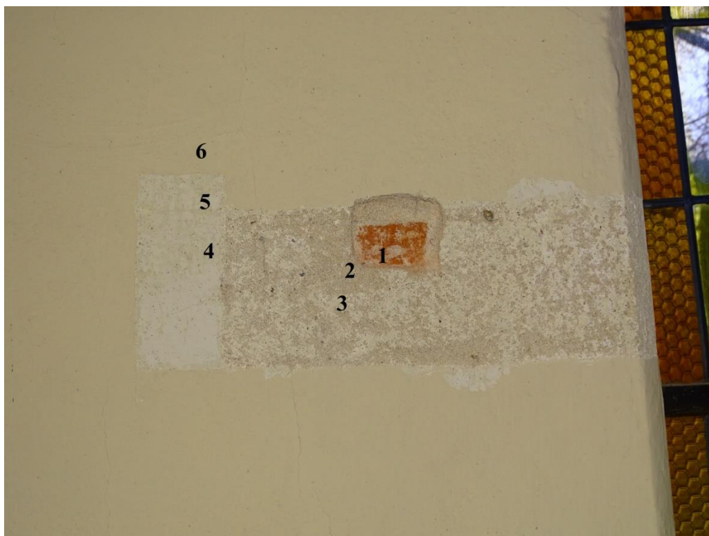
Fot. 31 Odkrywka nr 2 Część ścian nawy na drugiej kondygnacji - strona zachodnia
