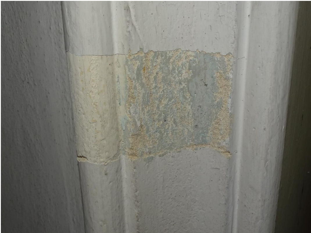
Fot. 39 Odkrywka 8 Detal sztukatorski na południowej ścianie nawy na wysokości drugiej kondygnacji empor po stronie zachodniej
