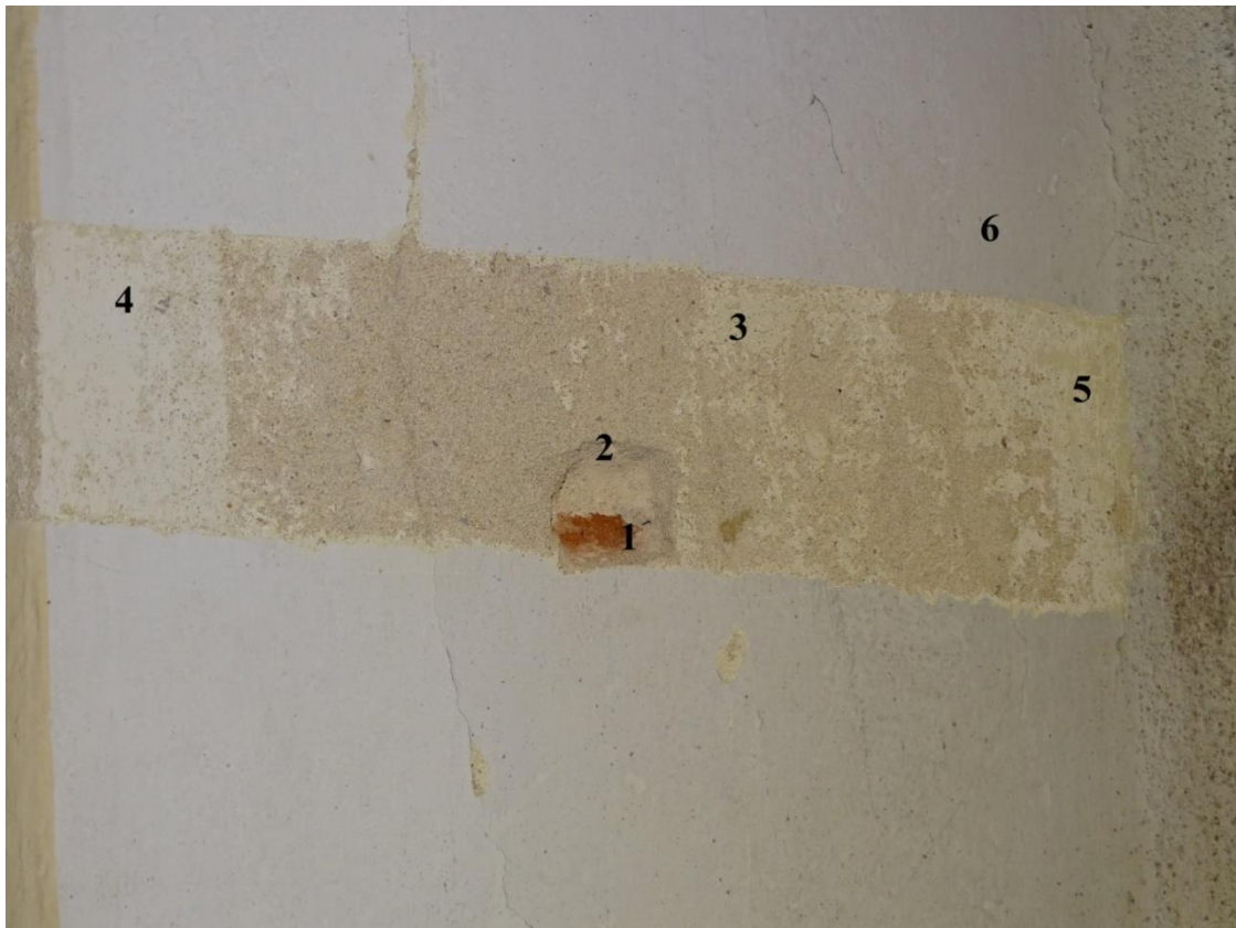
Fot. 32 Odkrywka nr 3. Głębokość glistu okiennego na drugiej kondygnacji - strona zachodnia
