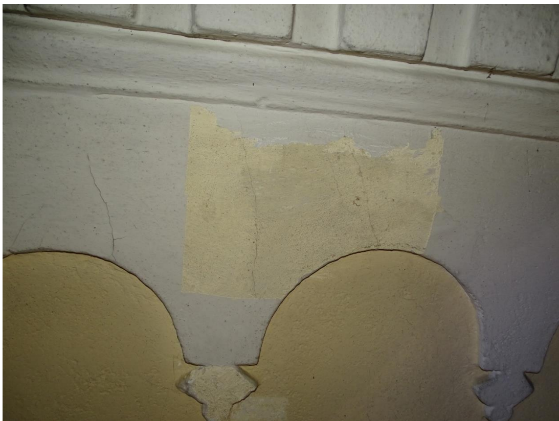
Fot. 40 Odkrywka 9 Detal architektoniczny w górnej części wschodniej ściany nawy
