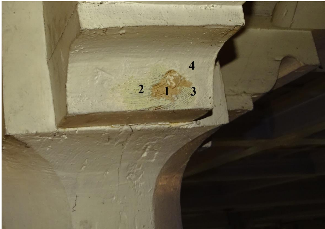
Fot. 59 Odkrywka 26 Odkrywka na powierzchni zwornika stropu nawy
