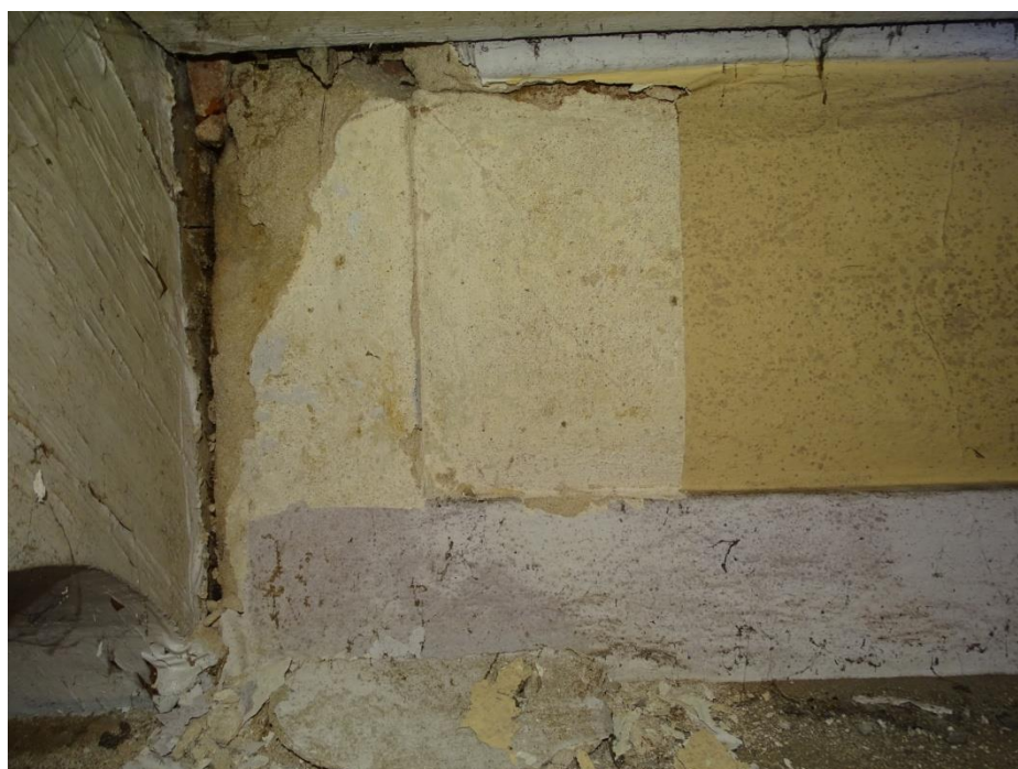
Fot. 42 Odkrywka 11 Detal architektoniczny w górnej części wschodniej ściany nawy
