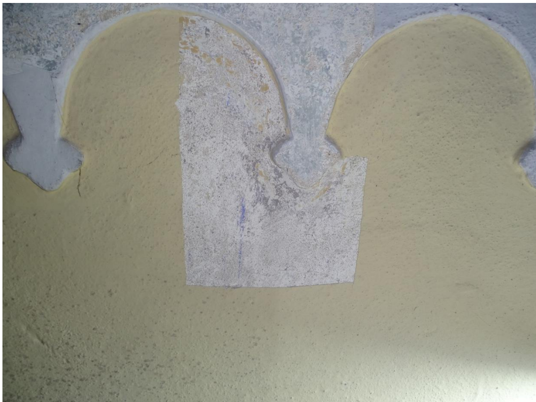
Fot. 51 Odkrywka 17 odkrywka na powierzchni fryzu arkadowego i ścian w prezbiterium
