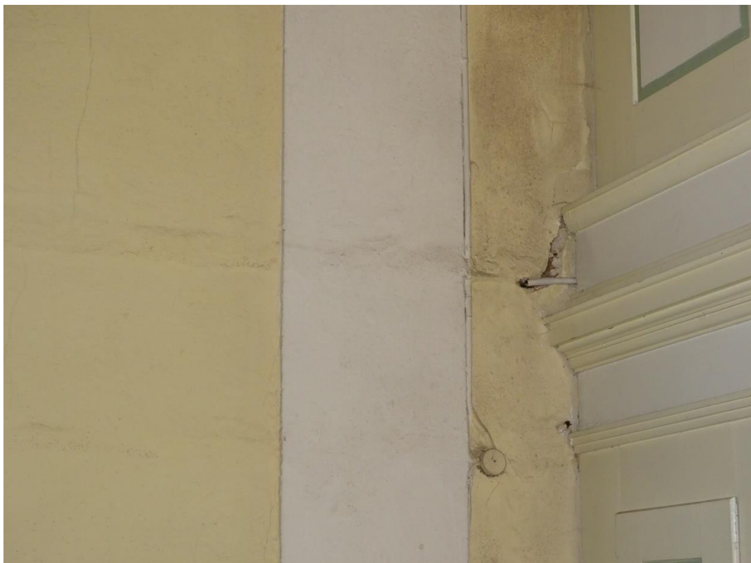
Fot.22 Zasolenia i zawilgocenia ścian w przyziemiu
