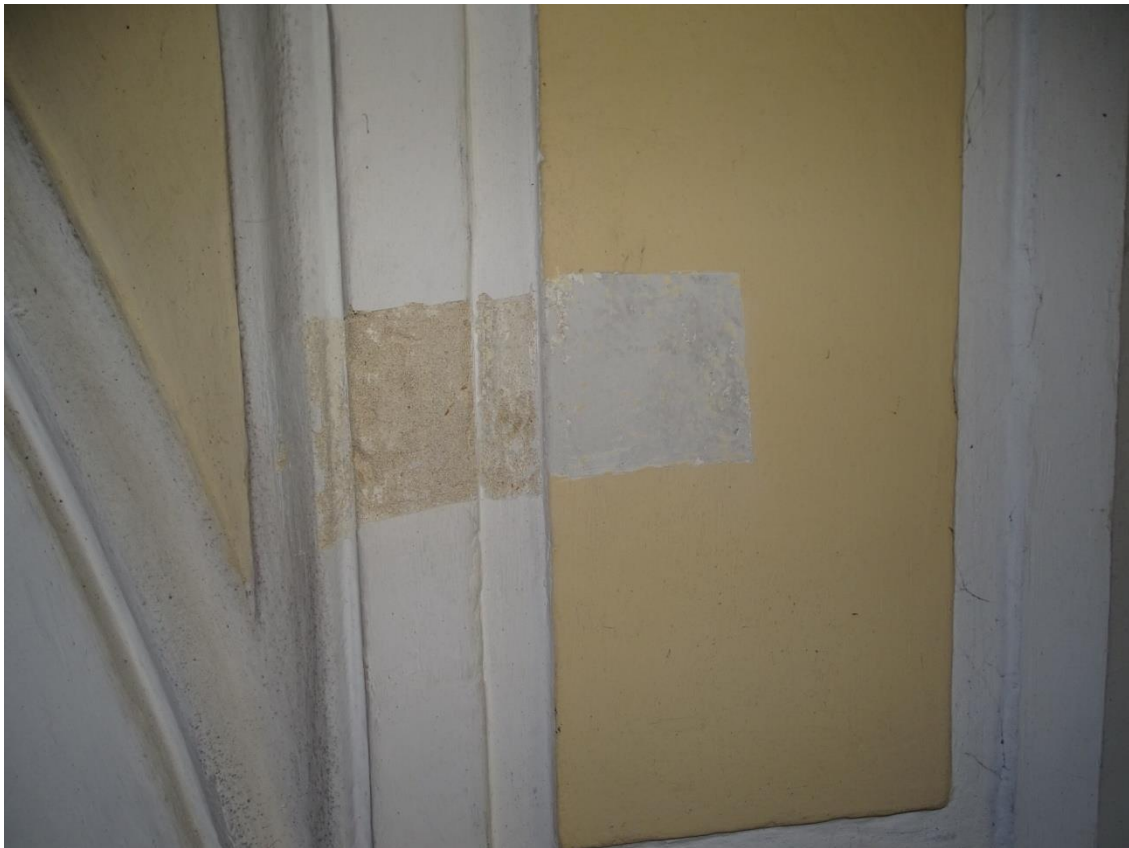
Fot. 44 Odkrywka 12 Detal architektoniczny w górnej części południowej ściany nawy
