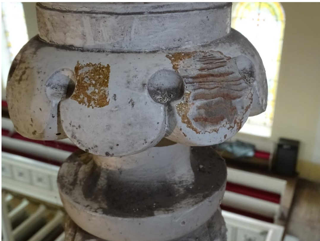
Fot. 61 Odkrywka 28 Odkrywka na powierzchni zwornika stropu nawy z widocznymi Złoceniami
