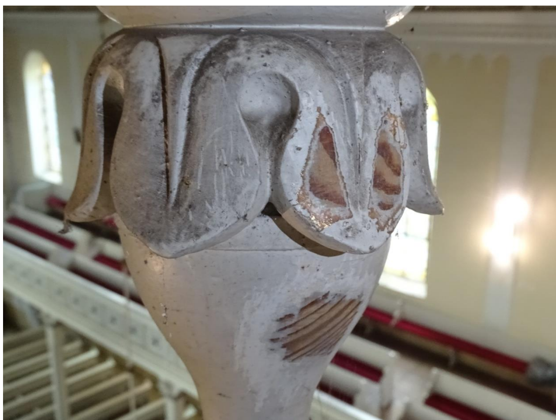
Fot. 62 Odkrywka 29 Odkrywka na powierzchni zwornika stropu nawy z widocznymi Złoceniami
