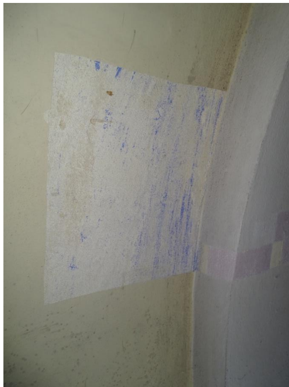
Fot. 49 Odkrywka 16 odkrywka na powierzchni sklepienia prezbiterium
