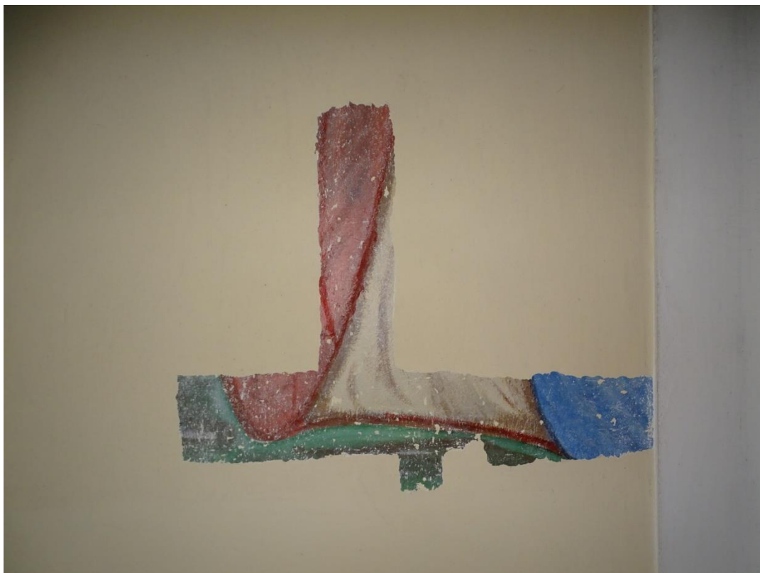
Fot. 37 Odkrywka 8 Południowa ściana nawy na wysokości drugiej kondygnacji empor po stronie wschodniej
