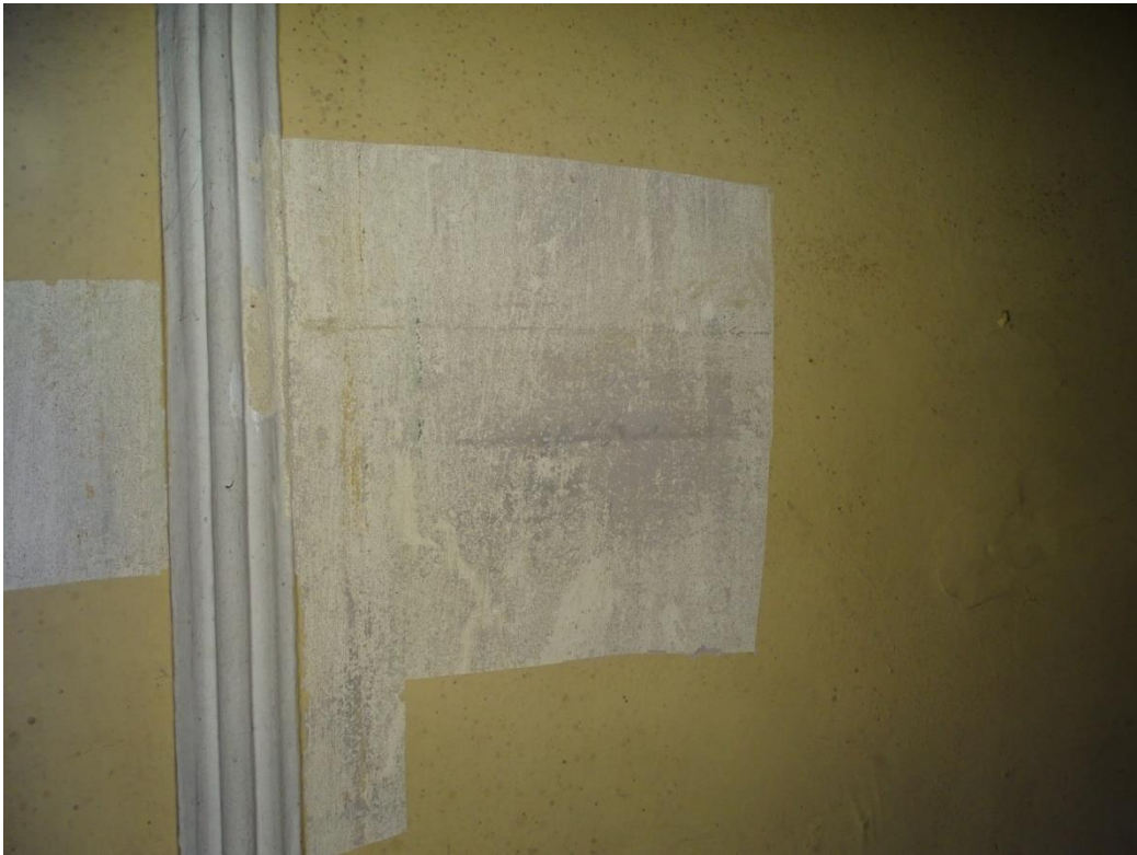
Fot. 52 Odkrywka 18 odkrywka na powierzchni ściany w trójbocznie zamkniętym Prezbiterium
