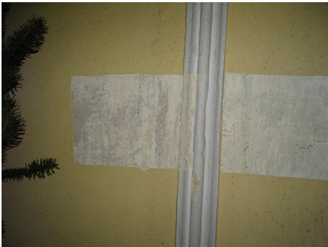
Fot. 54 Odkrywka 20 odkrywka na powierzchni ściany w trójbocznie zamkniętym Prezbiterium
