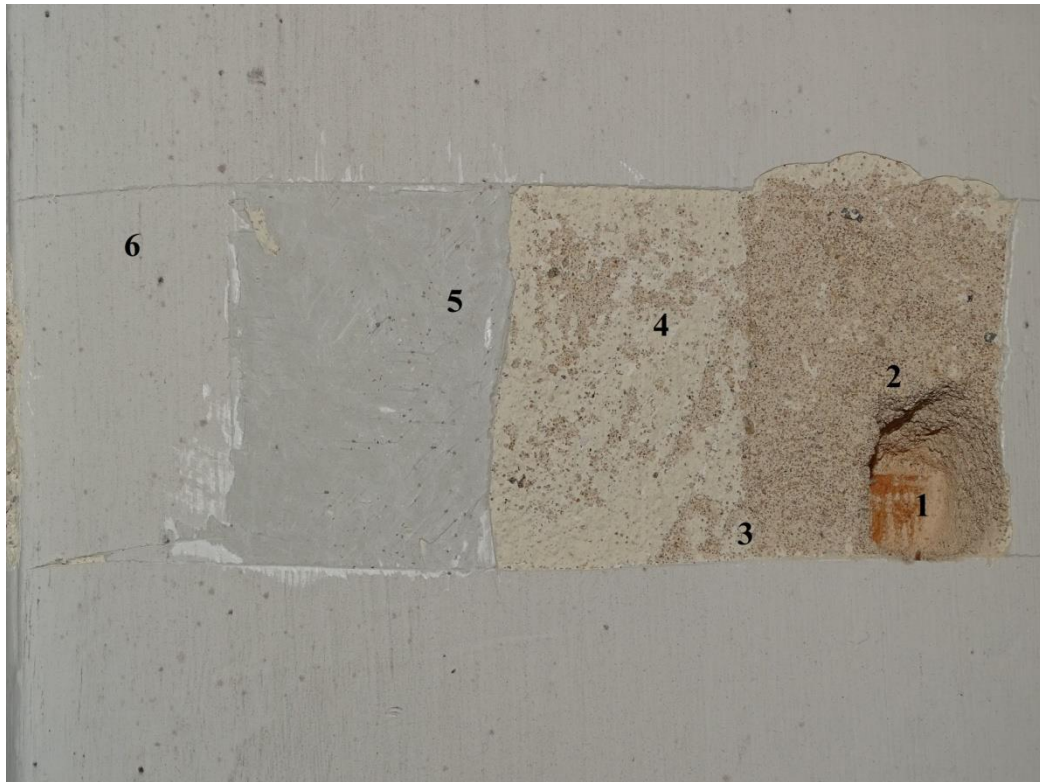
Fot. 35 Odkrywka 6 Południowa ściana nawy na drugiej kondygnacji empor
