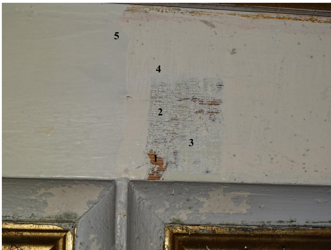
Fot. 63 Odkrywka 30 Odkrywka na powierzchni balustrady empory chóru
