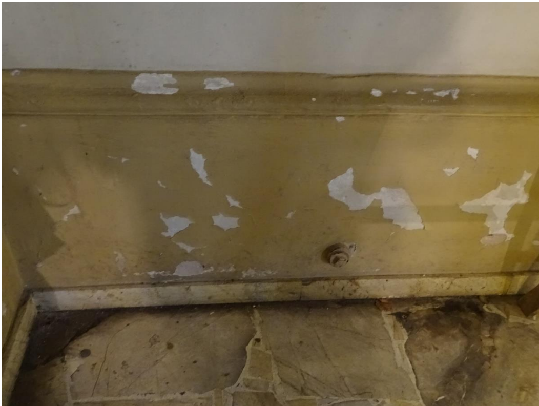
Fot.22 Zasolenia i zawilgocenia ścian w przyziemiu
