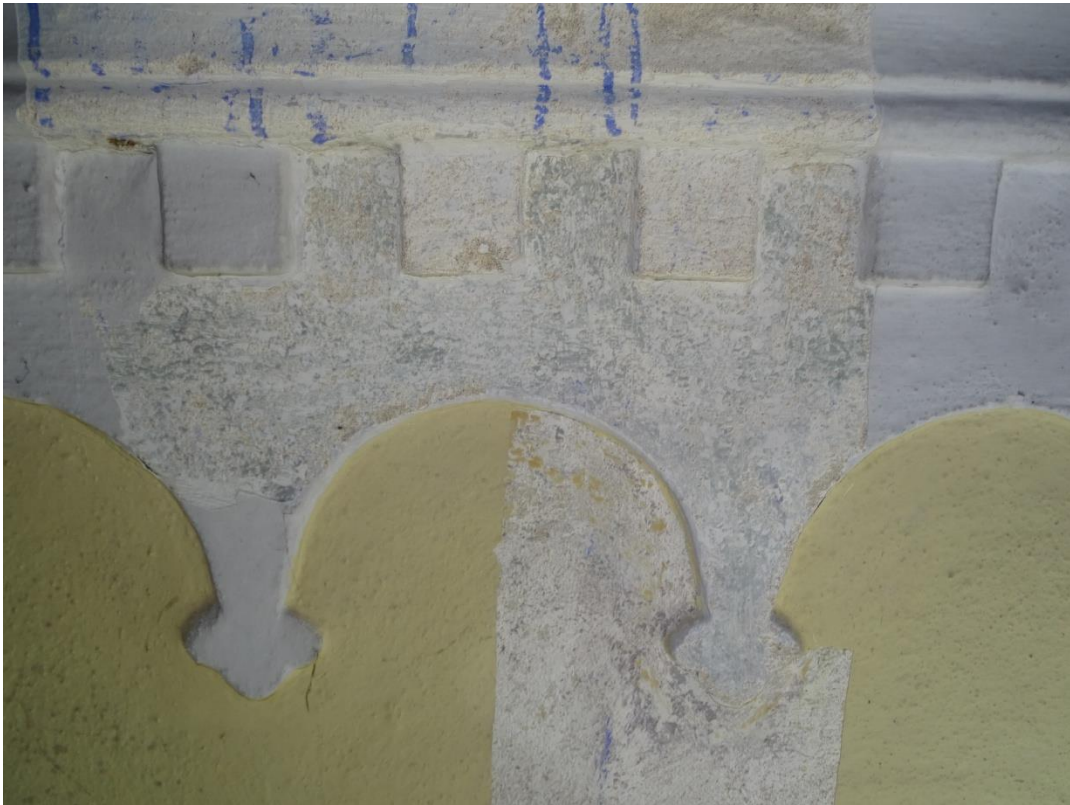
Fot. 50 Odkrywka 17 odkrywka na powierzchni fryzu arkadowego i ścian w prezbiterium
