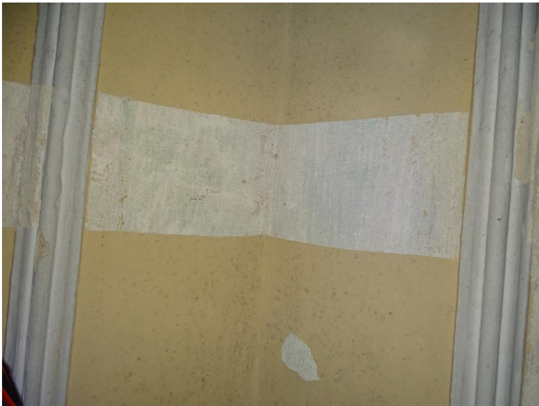
Fot. 53 Odkrywka 19 odkrywka na powierzchni ściany w trójbocznie zamkniętym Prezbiterium
