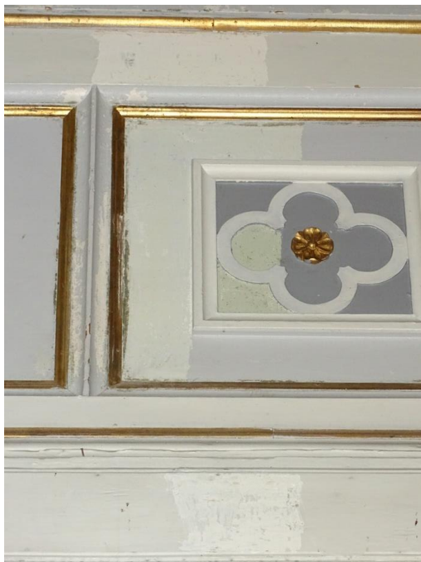
Fot. 65 Odkrywka 32 Odkrywka na powierzchni balustrady empory chóru
